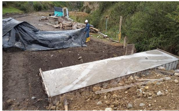
ARMADO Y FUNDICIÓN DE CANAL DE ENTRADA DEL AGUA TURBINADA
