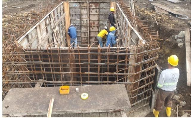
FIGURADO DE ACERO DE REFUERZO Y ENCOFRADO DE CARCAMO DE SUCCION
