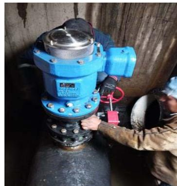
FABRICACIÓN Y COLOCACIÓN DE ACCESORIOS MECÁNICOS EN CÁMARAS. INSTALACIÓN DE VÁLVULAS DE AIRE Y MARIPOSA EN LÍNEA DE AGUA TRATADA
