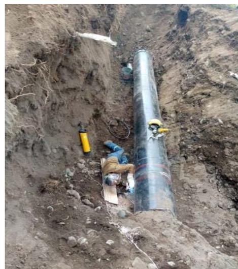
COLOCADO DE TUBERÍA QUE UNE LA IMPULSIÓN DESDE LA ESTACIÓN DE BOMBEO A LA LÍNEA DE GRAVEDAD ENTRE LA CÁMARA DE CHECK #1 Y EL PUENTE COLGANTE DEL RÍO CHAMBO
