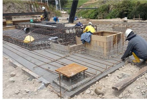
FIGURADO DE ACERO DE REFUERZO EN LOSA DE MANIFOLD
