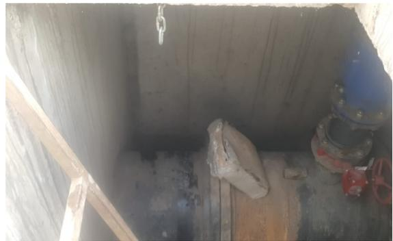
INSTALACIÓN DE VÁLVULAS MARIPOSA Y AIRE EN LÍNEA DE CONDUCCIÓN DE AGUA CRUDA. FABRICACIÓN DE ELEMENTOS MECÁNICOS
