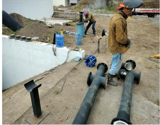
INSTALACIÓN DE JUNTAS DESMONTABLES Y ELEMENTOS MECÁNICOS EN GALERÍA DE RECOLECCIÓN DE LODOS
